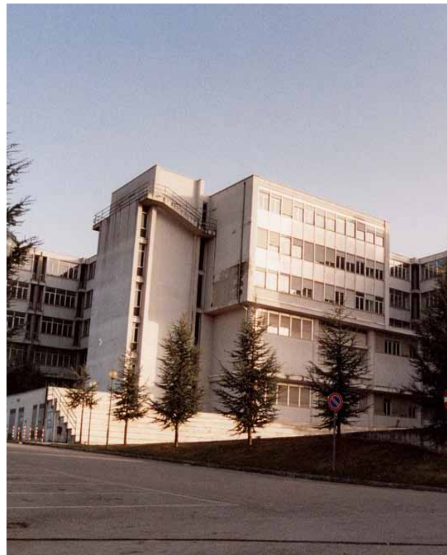
Complesso di Via Calandra Sede della Facoltà di Giurisprudenza
